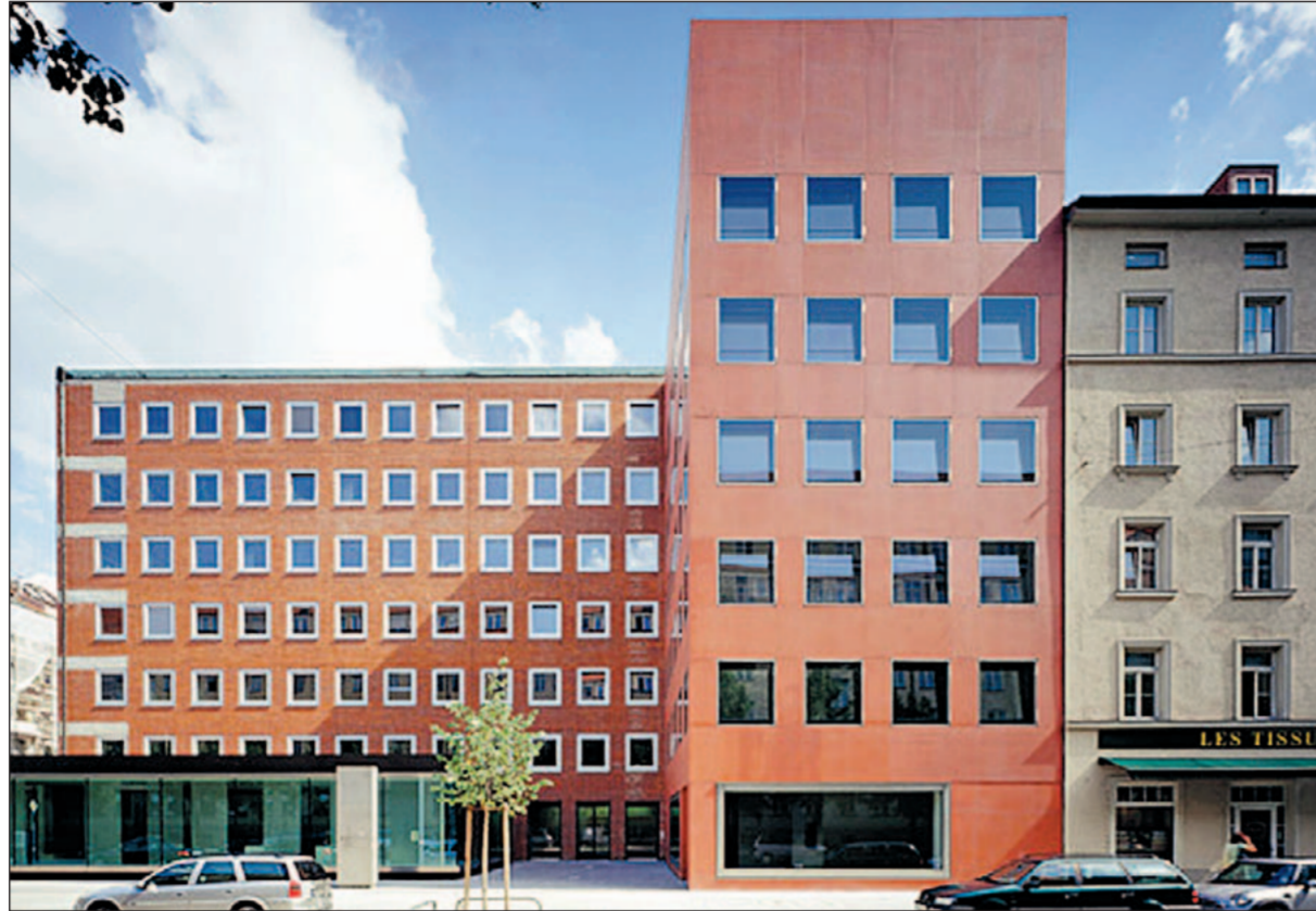
Die farbige Betonfassade des Neubaus in der Münchner Blumenstraße.
